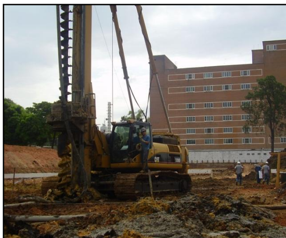
Foto 5. Condomínio residencial em construção, em primeiro plano. Em segundo, moinho de trigo em funcionamento desde a década de 1950. Lívia Fioravanti. 11 abr. 2009.
