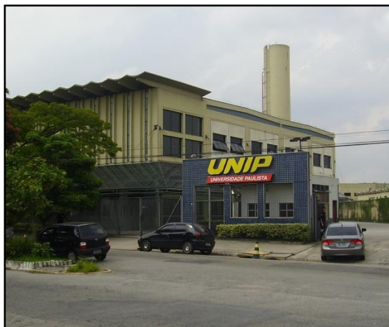
Foto 3. Faculdade cuja construção aproveitou antigo galpão industrial. Lívia Fioravanti. 02 fev. 2009.
