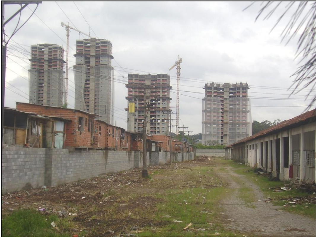
Foto 27. Em primeiro plano à esquerda, algumas casas da favela Beira Linha. À direita, depósito de madeiras do IPT. Em segundo plano, Condomínio Horizontes Cidade Universitária. Lívia Fioravanti. 08 nov. 2009.
